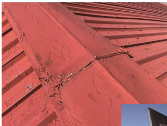
トタン屋根の劣化が進んで雨漏りが起きています。信徒による塗装、補修では解決できなくなりました。
