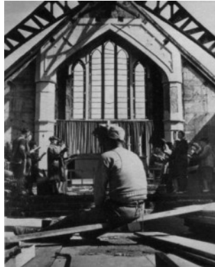
1947 年 修復工事中の 大工さん
